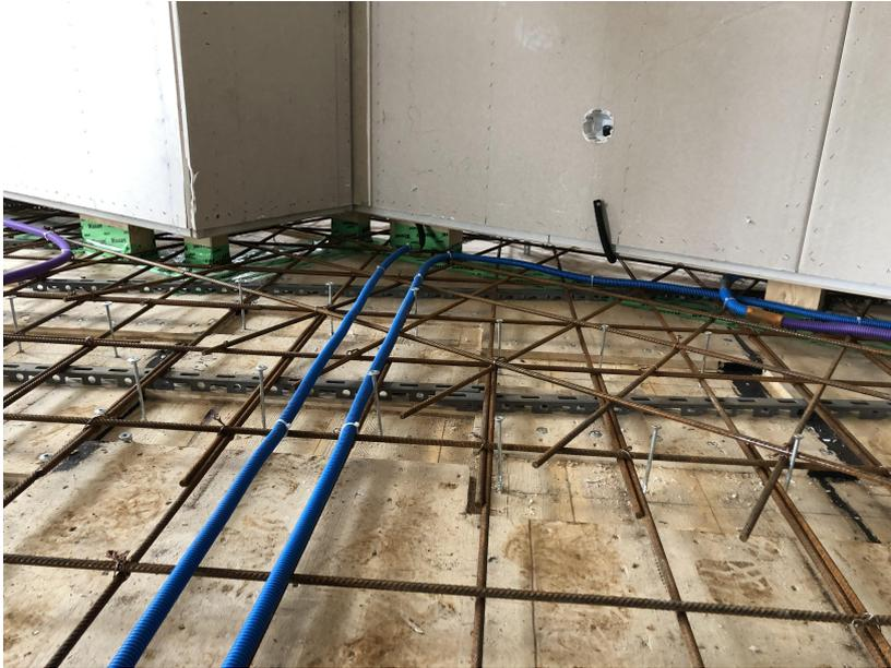
*Abbildung 63 Durchgehende Betonscheibe ohne Schallschutzlager bei der Wohnungstrennwand, Bild: Hannes Rettenwander, Exkursion Schweiz.*
