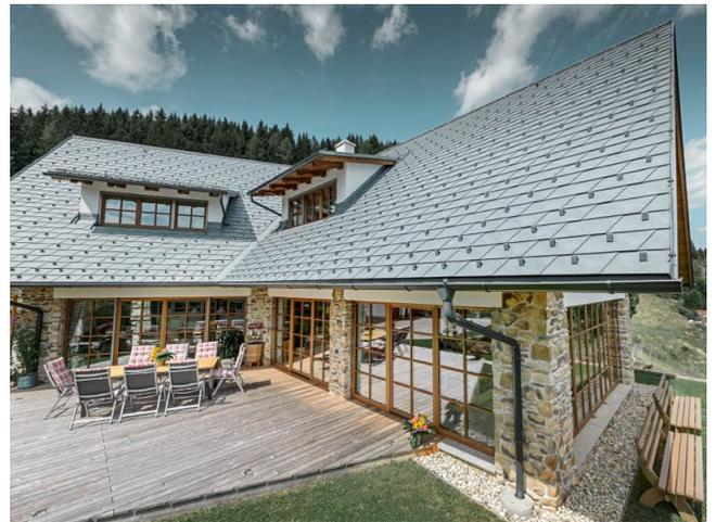
Abbildung 42 Fa. PREFA Dachplatten ab 12° Dachneigung.
