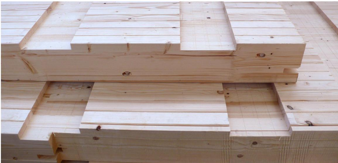
Abbildung 50 Brettstapeldecke mit Kerven als Verbindungsmittel
