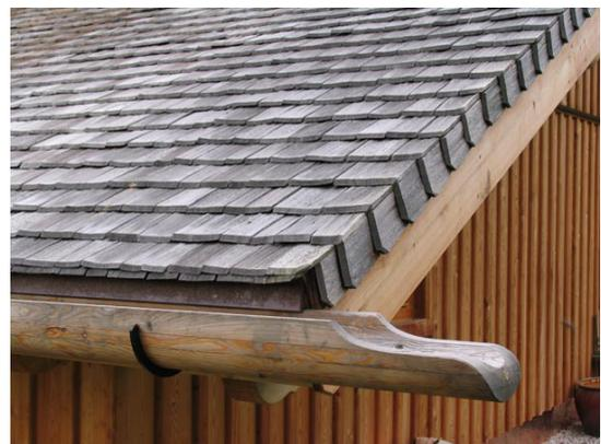
Abbildung 30 Ortgang durch ein mitgedecktes Rollgebilde und Traufe mit Holzdachrinne.
