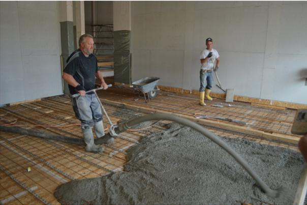
Abbildung 55 Betonvorgang, Bild: Merz, Konrad, Gymnasium Diedorf.
