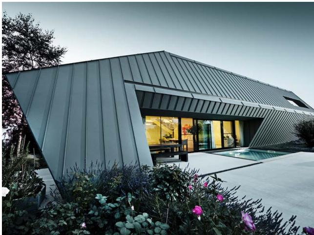
Abbildung 41 Fa. PREFA Doppelstehfalzdach ab 3° Dachneigung.
