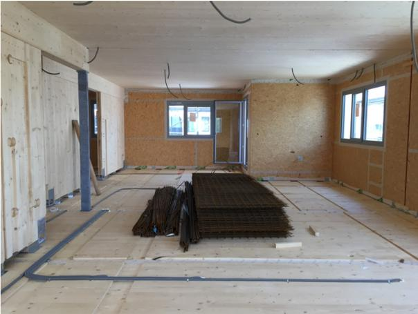
Abbildung 53 Bewehrung einlagern, Installationsführung hinter der Kerne, Bild: Merz, Konrad, Paulasgasse Wien.
