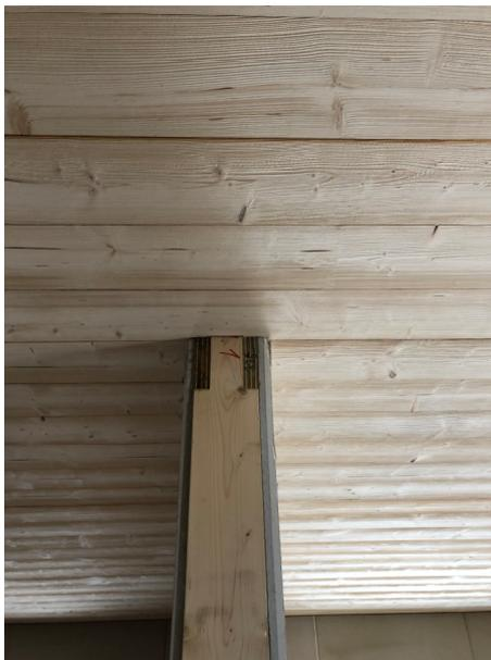
*Abbildung 61 Deckenuntersicht HBV-Decke mit Massivholz, Oberfläche unbehandelt, gebürstet, Bild: Hannes Rettenwander, Exkursion Schweiz.*
