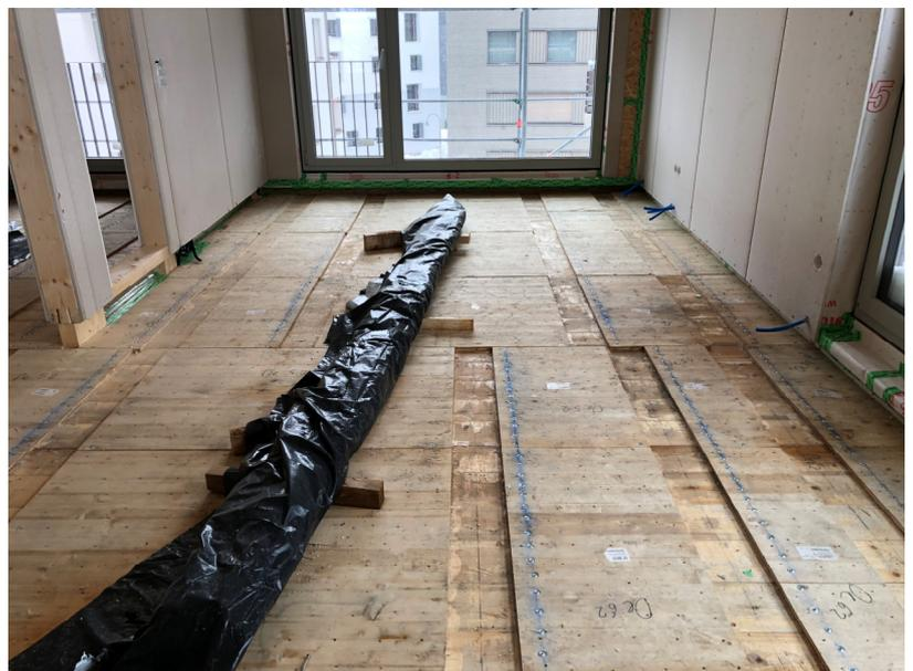
*Abbildung 62 Holzdecke ohne Aufbeton, mit 22 mm Dreischichtplatten als Elemente vorgefertigt und der gelagerten Bewehrung, Bild: Hannes Rettenwander, Exkursion Schweiz.*
