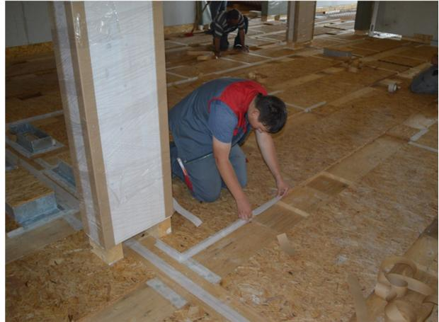
Abbildung 54 Fugen, Schutz der Säule, Bild: Merz, Konrad, Gymnasium Diedorf.
