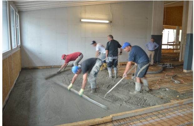
Abbildung 56 Betonieren, Handling des Pumpschlauchs hinten rechts Bild: Merz, Konrad.
