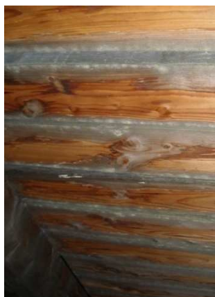
Abbildung 6, Untersicht Holzterrasse, frei abtropfend
