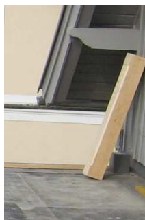
Abbildung 23, Stützeinfassung bei zweiteiligen Holzstützen aus Brettschichtholz, A-1230 Wien
