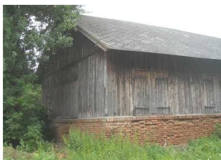
Abbildung 5, Unterschiedliche Vergrauung an Holzstadel, A-2320 Schwechat, Schwarzmühlstraße 7
