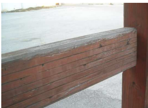
Abbildung 2, Brüstungsbalken aus Brettschichtholz
