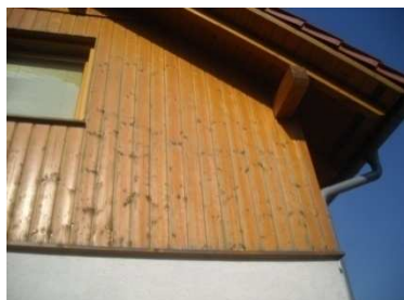
Abbildung 15, Nut/Federschalung senkrecht, A-2380 Perchtoldsdorf
