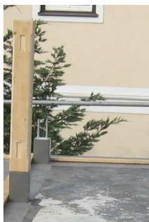
Abbildung 23, Stützeinfassung bei zweiteiligen Holzstützen aus Brettschichtholz, A-1230 Wien
