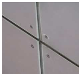
Abbildung 19, Fassade mit Prodemaplatten, Bj. ca. 1990, 1230 Wien
