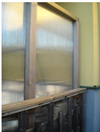
Abbildung 18, Vergleich Leimholzrahmen mit Adler Silverwood, verwittertes Lärchengeländer
