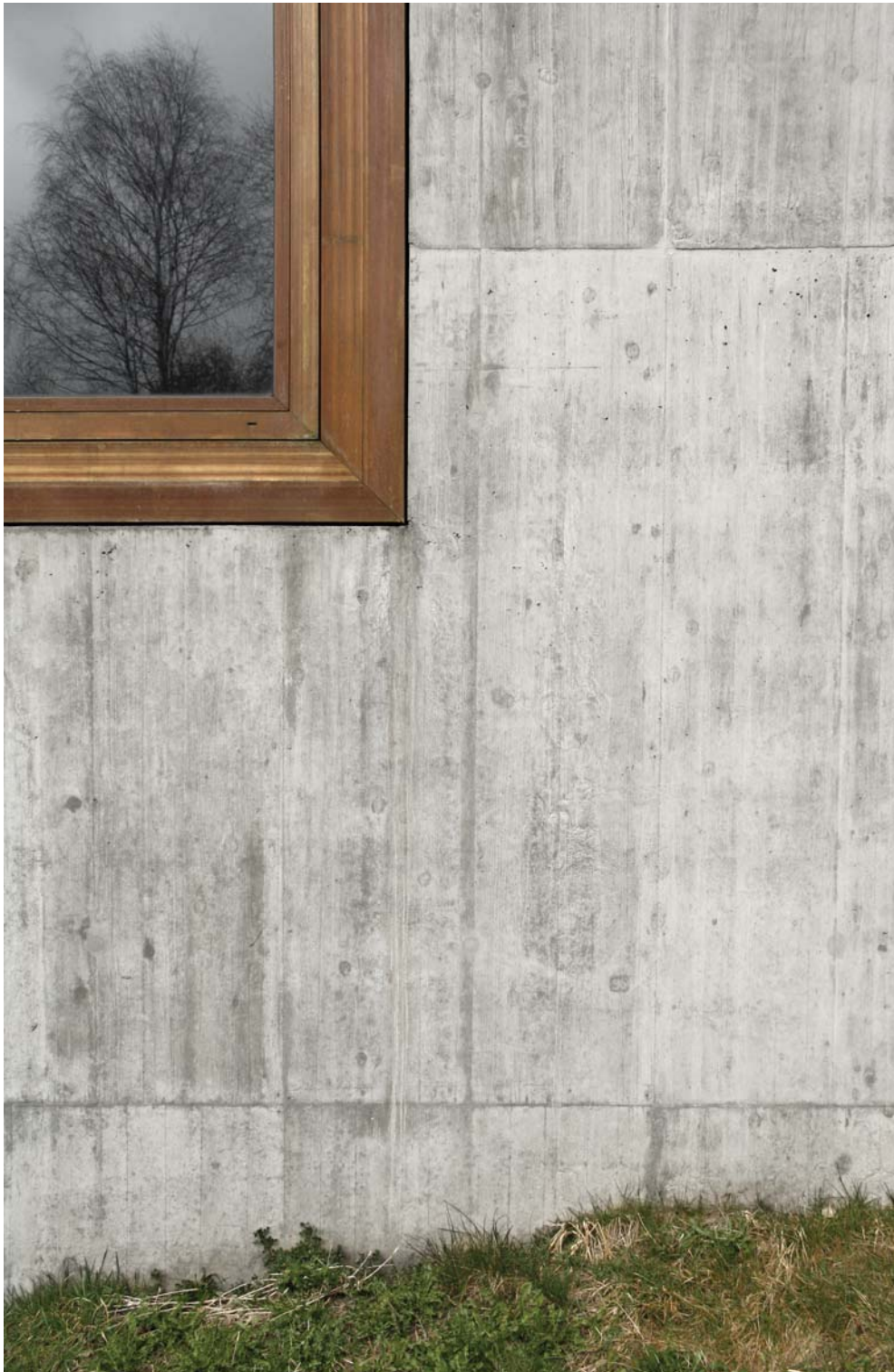
Fassadenbündiges Gangfenster
