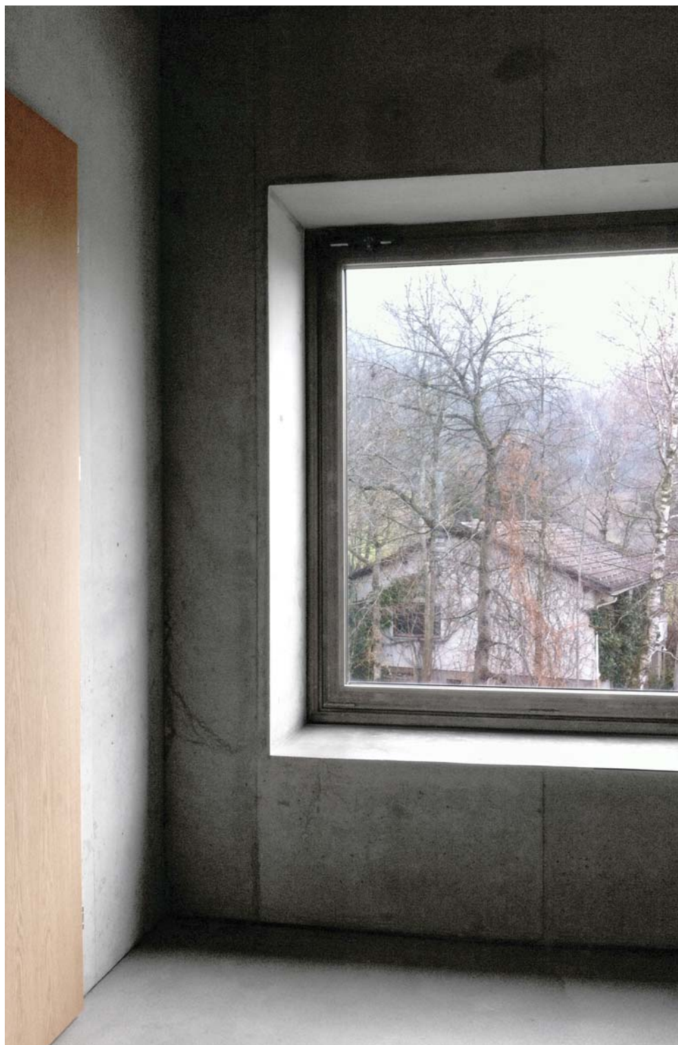
Tiefe Fensterlaibung als Sitznische
