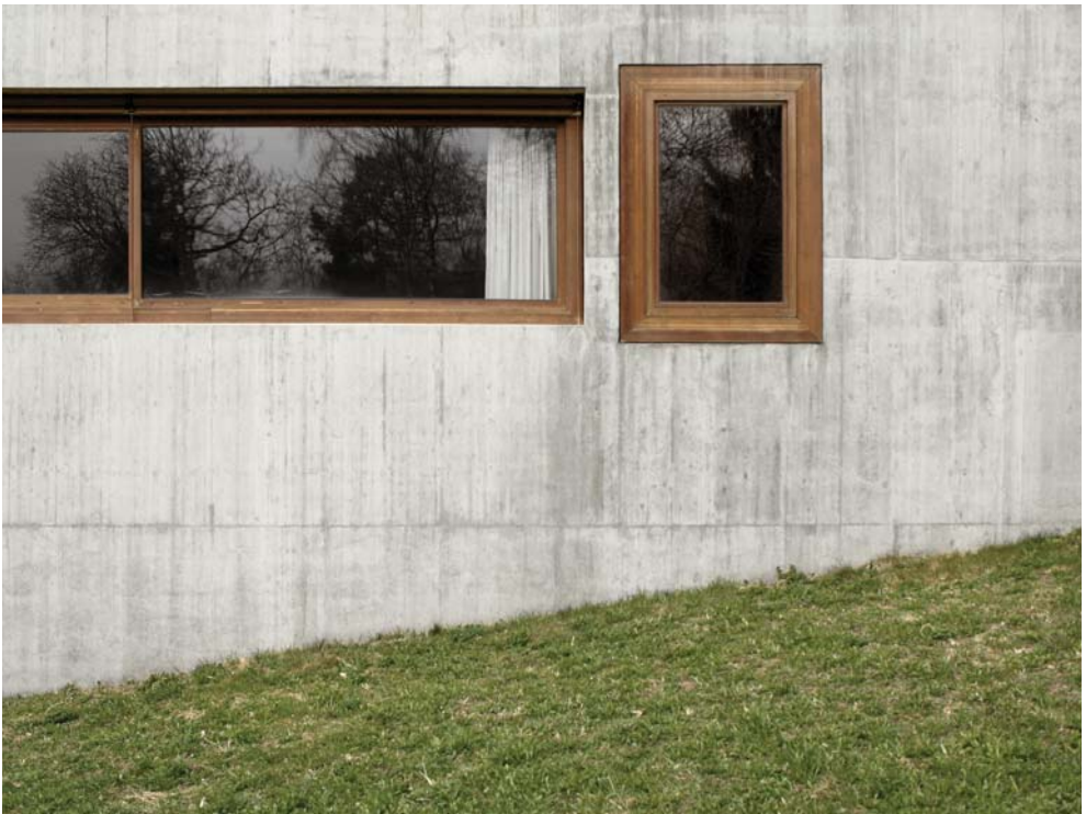
Fenster Klassenzimmer und Gangbereich
