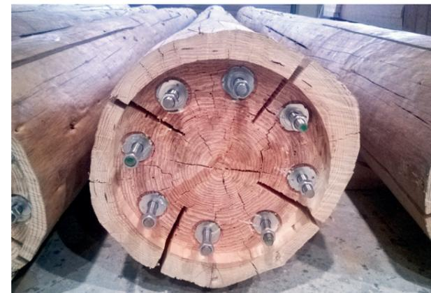
Bild timbatec / Einklebte Gewindestangen
