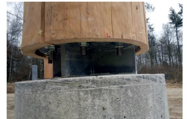
Bild timbatec / Montierter Stützenfuss
