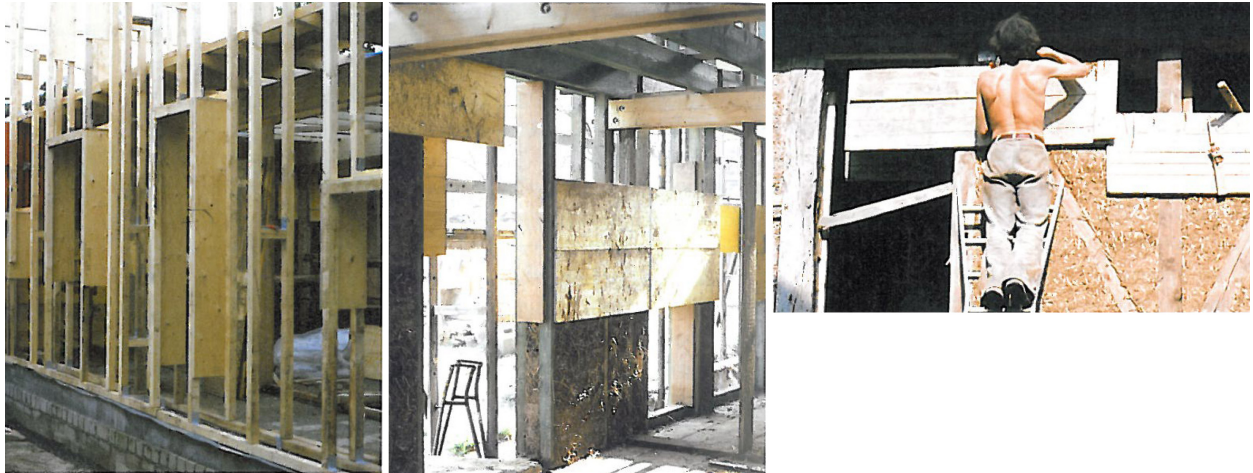
Abb. 13. Klassische Holzständerwände, die händisch mit Lehm ausgefacht werden.
