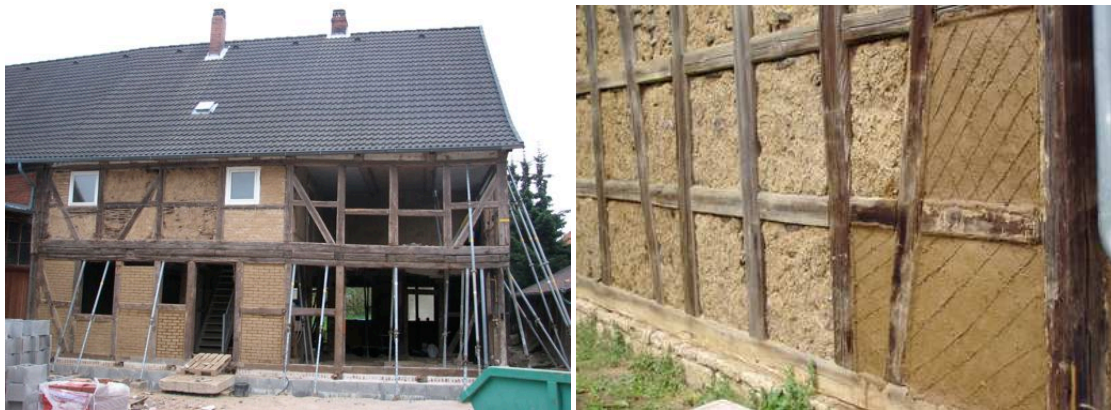
Abb. 4. Sanierung eines alten Fachwerkhäuses mit Lehmausfachung
