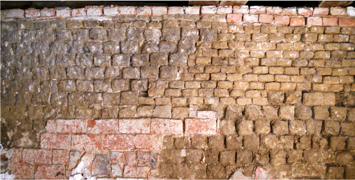
Abb. 7. Vom Putz freigelegte Aussenmauer bei der Renovierung eines alten Lehmhauses im Weinviertel.
