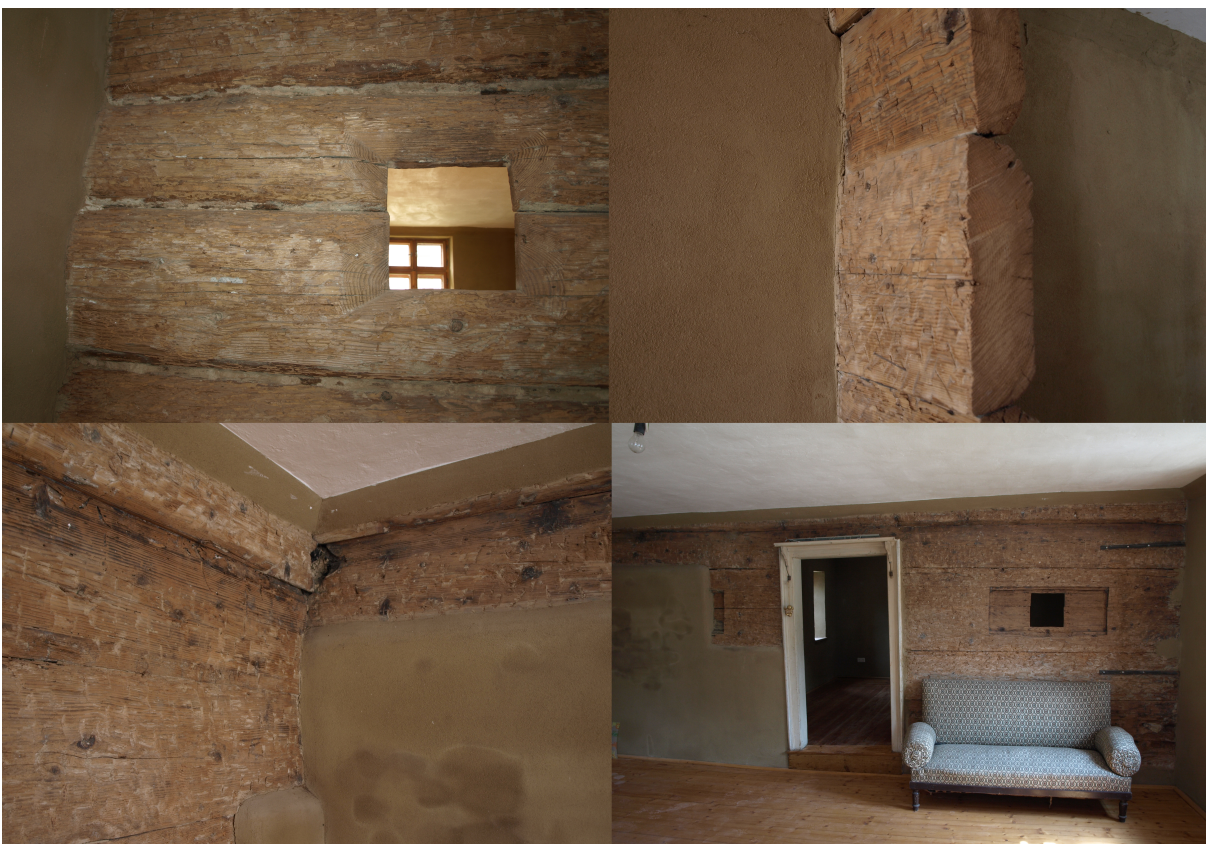
Abb. 3: Holzblockhaus mit Lehmputz aus dem Jahre 1290 mit intakten und unversehrten Blockbohlen.
