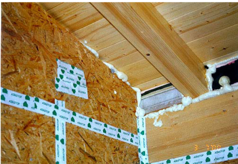
Abb. 8: OSB Platte, Klebebänder und Schäume sind notwendig um eine innere luftdichte Ebene zu erzeugen, die speziell an den Stößen und Übergängen ein großes Risiko für falsche Ausführung birgt.
