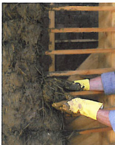
Abb. 14. Händisches Einbringen von Leichtlehm auf Latten einer vorgefertigten Holzständerkonstruktion
