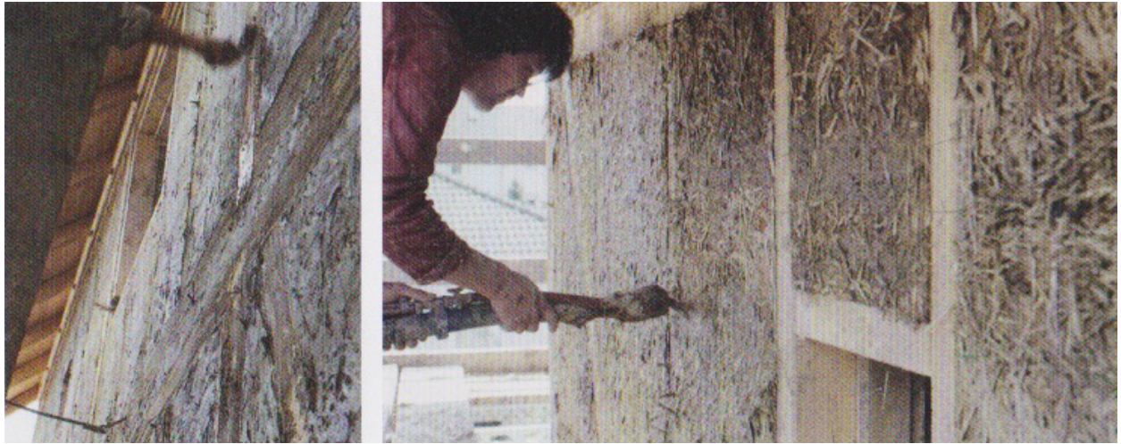
Abb. 40. Links: Lehmverstrich mit einem Pinsel aufgetragen. Rechts: Lehmverstrich maschinell aufgetragen.
