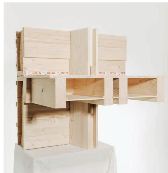
Oliver King: konsequente Trennung von tragender Konstruktion und thermischer Hülle
